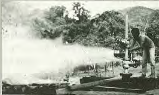
น้ำร้อนและไอน้ำร้อนจากหลุมเจาะสำรวจแหล่งพลังงานใต้พิภพฝาง อำเภอฝาง จังหวัดเชียงใหม่
