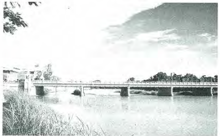
สภาพสะพานนารัตน์ เมื่อ พ.ศ. 2527 (ปัจจุบัน)
